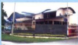
Kompleks Pusat Kejuruteraan & Dewan Kuliah
