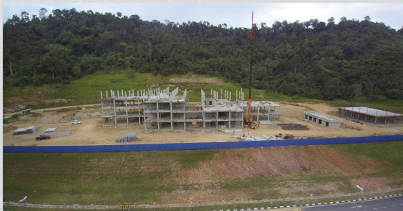
Gambar 2: Tapak Cadangan Bangunan Canselori / Pendaftar & Bendahari (22% Siap)
